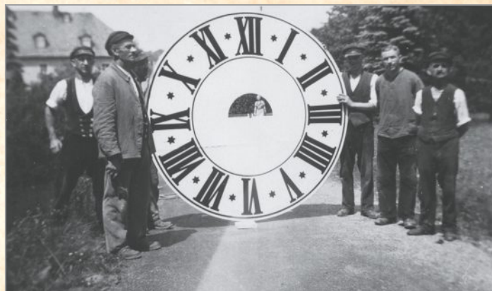
Erneuerung der Ziffernblätter (noch mit römischen Zahlen)
